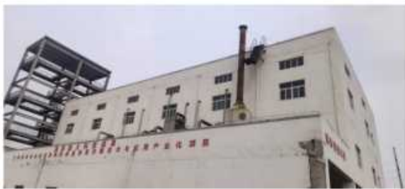
固体车间治理设施
