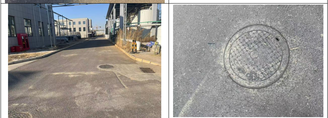
雨水管、雨水口、排水管、硬化
