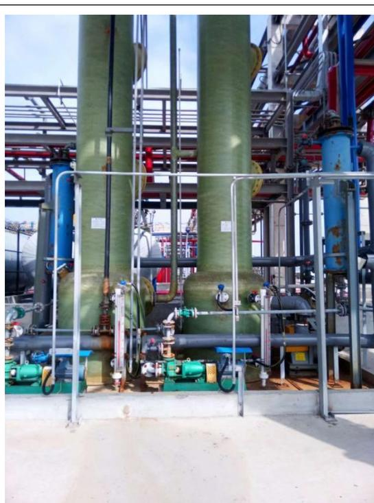
罐区卤素废气经预处理碱洗塔+碱洗塔处理
