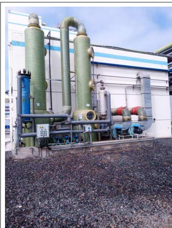
液氯钢瓶库废气经预处理碱洗塔+碱洗塔处理
