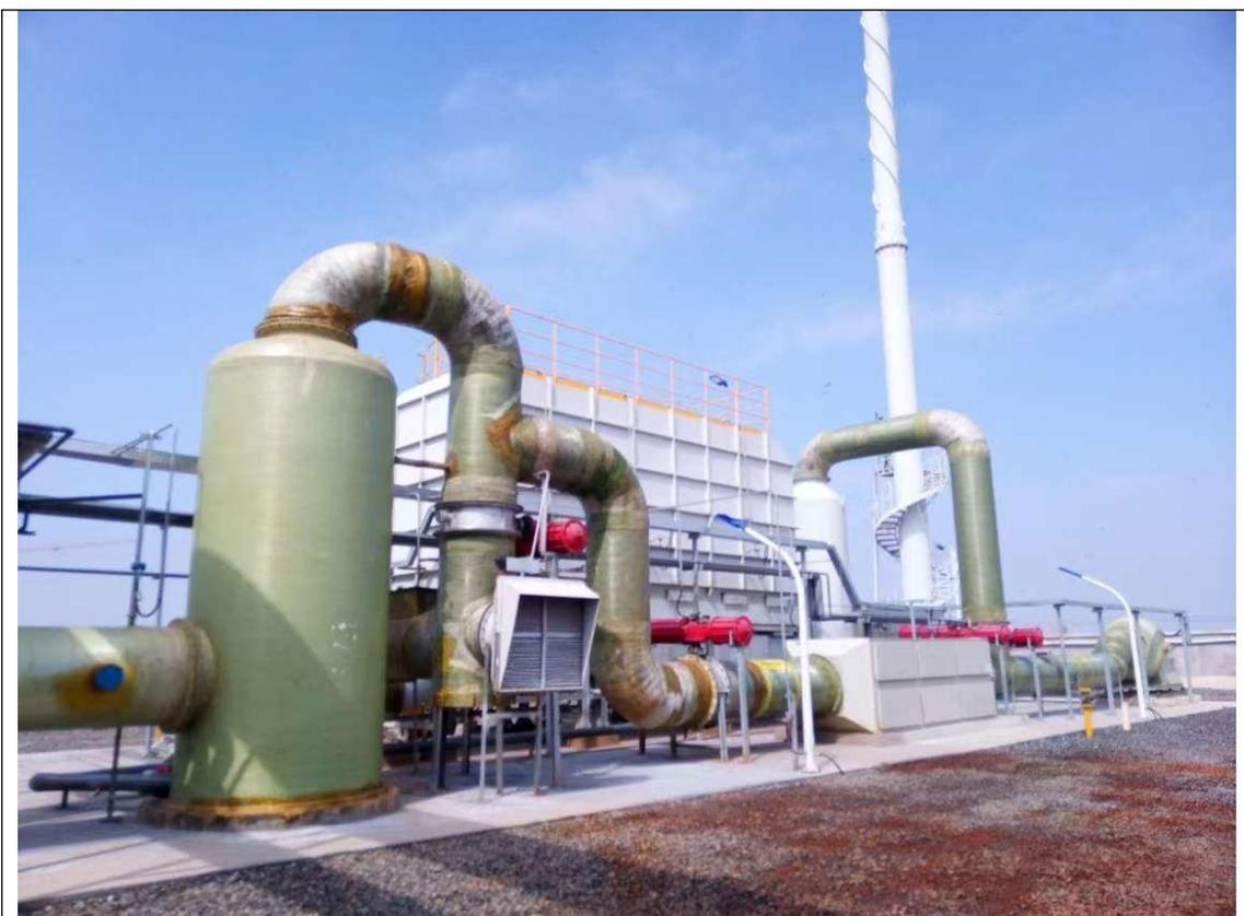
碱洗塔+水洗塔+气液分离+RTO 蓄热氧化装置+水洗塔+30m 高排气筒 (DA002)
