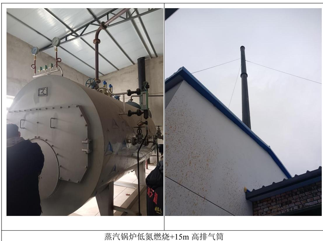
蒸汽锅炉低氮燃烧+15m 高排气筒
