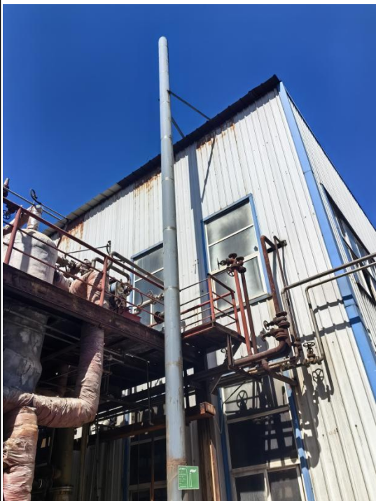
旋风除尘+布袋除尘+15m 高排气筒(DA027)
