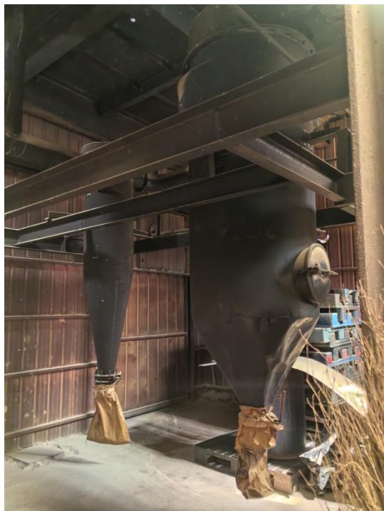
旋风除尘+布袋除尘+15m 高排气筒(DA027)
