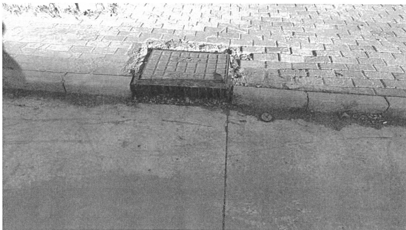
图 3 地面硬化及雨水口现状照片
